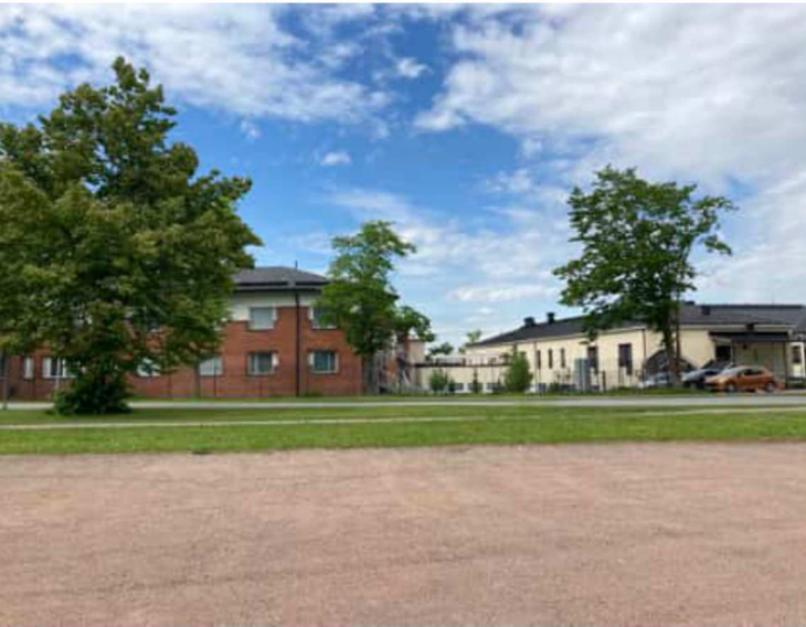
Härkikujan länsipuolella sijaitseva sairaala
